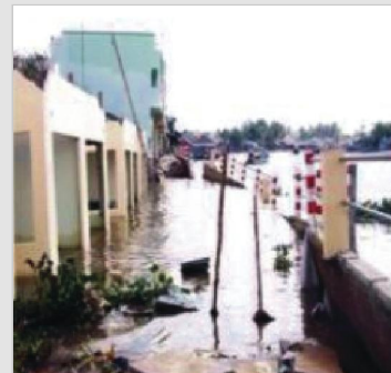
Sạt lở đất ở dọc bờ sông
