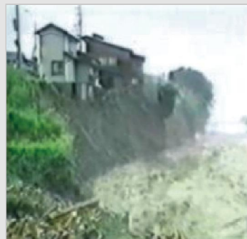
Sụt lở bờ sông khi có lũ lớn
